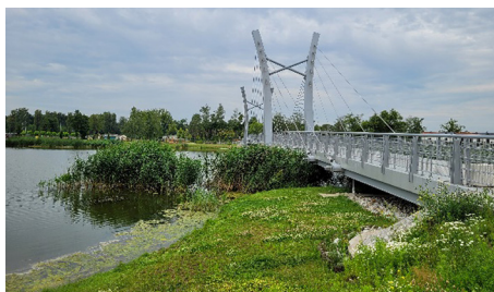
Fot. 4. Kładka pieszo-rowerowa
