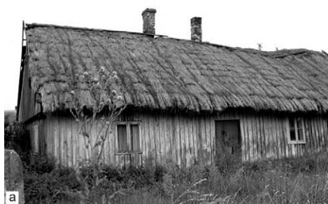
Fot. 6a. Budynek mieszkalny o konstrukcji szachulcowej z zewnętrznym deskowaniem, przestrzeń pomiędzy belami wypełniona gliną, słomą lub igliwem oraz torfem. Szerość podmurówki odpowiada grubości ryglówki. Dach kryty słomą, z okapem. Budynek opuszczony
