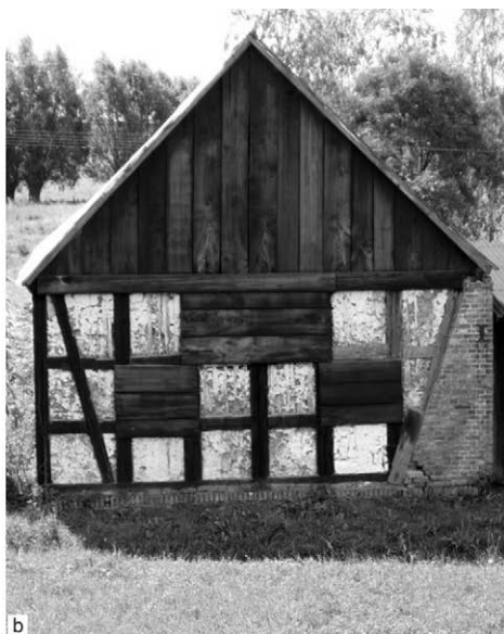
Fot. 4a. Budynek mieszkalny o konstrukcji szachulcowej, przestrzeń pomiędzy belkami wypełniona gliną, słomą lub igliwim oraz torfem. Szerokość podmurówki odpowiada grubości ryglówki. Szczyty budynku w deskowaniu. Budynek opuszczony
