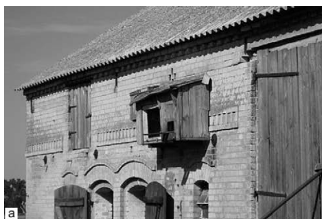
Fot. 5a. Budynek gospodarczy z cegły wapienno-piaskowej, w części dwukondygnacyjny, drzwi i okna mają opaskę, zakotwienia belek konstrukcyjnych są ozdobne, dach dwuspadowy o kącie nachylenia 25–30°, widoczne miejsca wentylacyjne. Budynek użytkowany
