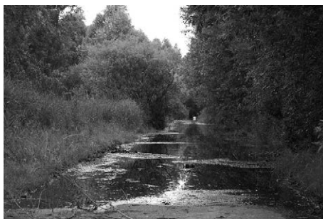
Fot. 4. Zalane drogi w południowo-zachodniej części zbiornika (fot. M. Cichoń)
