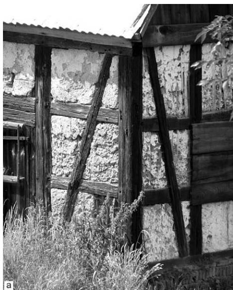
Fot. 4a. Budynek mieszkalny o konstrukcji szachulcowej, przestrzeń pomiędzy belkami wypełniona gliną, słomą lub igliwim oraz torfem. Szerokość podmurówki odpowiada grubości ryglówki. Szczyty budynku w deskowaniu. Budynek opuszczony
