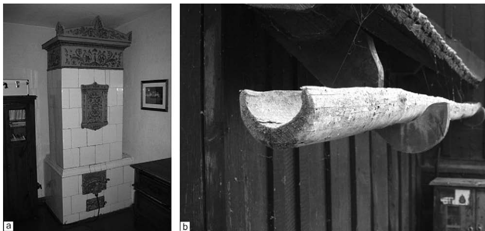
Fot. 10a. Piec zwykły z białych kafli glazurowanych, z ozdobnym wykończeniem, bez multiplikatora, do otrzymania właściwej powierzchni pieców, odpowiadającej objętości lokalu trzeba było liczbę metrów sześciennych jego objętości podzielić przez 20, powierzchnia ta wypadła wówczas bardzo duża, dlatego w jednym pomieszczeniu instalowano dwa, a nawet trzy piece
