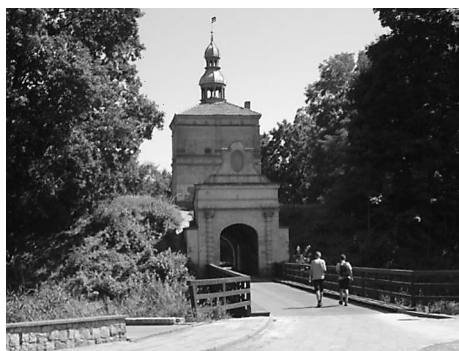
Ryc. 3. Wieża bramna w Zbąszyniu (źródło: www.zbaszyn.pl )
