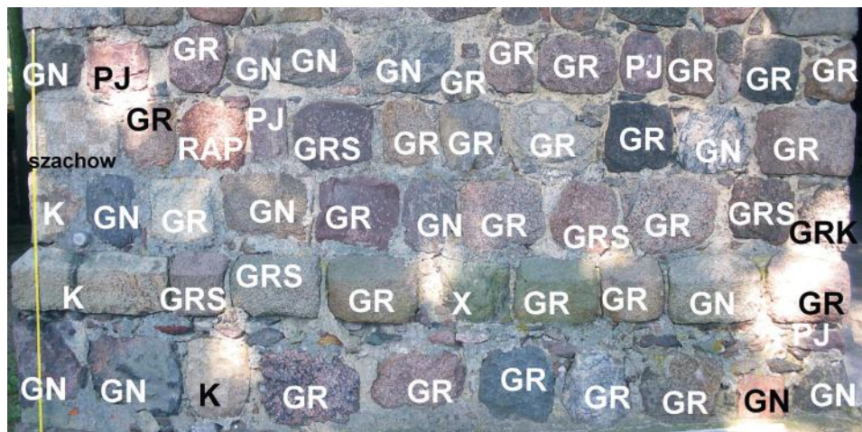
Fot. 2. Wyniki analizy petrograficznej fragmentu ściany południowej kościoła pw. Ducha Świętego w Moryniu. W lewym górnym rogu zdjęcia widoczny ornament zdobiący w postaci szachownicy, autorki analizy: Magdalena Sroka i Maria Górska-Zabielska GR – granit, GRK – granit Karlshamn, GRS – granit Småland, RAP – alandzki granit rapakivi, PJ – piaskowiec jotnicki, GN – gnejs, K – kwarcyt, X – skała niez rozpoznana
