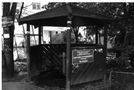
Fot. 5. Ujęcie wody z pokładów czwartorzędowych, eksploatowanej z głębokości 29,5 m p.p.t., przy ul. Prusa
