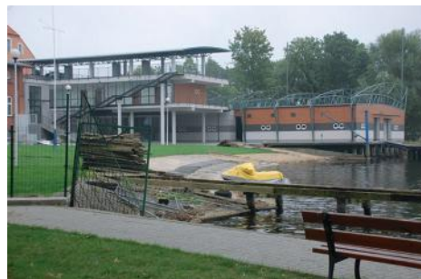
Fot. 2. Całoroczny brak dostępności brzegowej i wodnej jeziora Trzesiecko w Szczecinku w wyniku wybudowania Centrum Ekologicznego – wrzesień 2015 r. (fot. M. Cichoń)
