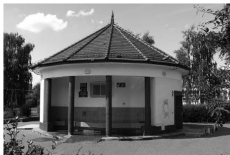
Fot. 4. Ujęcie wody przy ul. Jasnej z oligoceńskiej warstw wodonośnych zalegających na głębokości 244 m ppt
