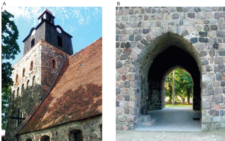
Fot. 1. A – wieża przejazdowa dobudowana w 1350 r. do kościoła pw. Ducha Świętego od strony zachodniej; B – przejazd pod wieżą o kształcie ostrego łuku; poza częścią zegarową wieża zbudowana z obrobionych kamieniarsko głazów narzutowych
