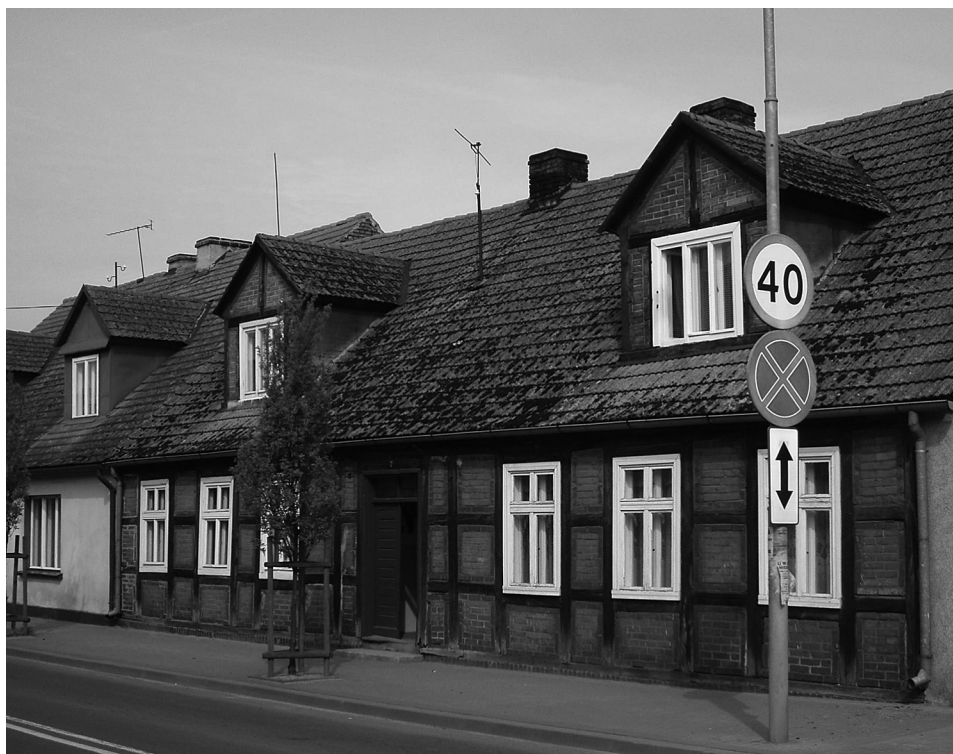
Fot. 4. Sieraków, dom przy ul. Chrobrego
