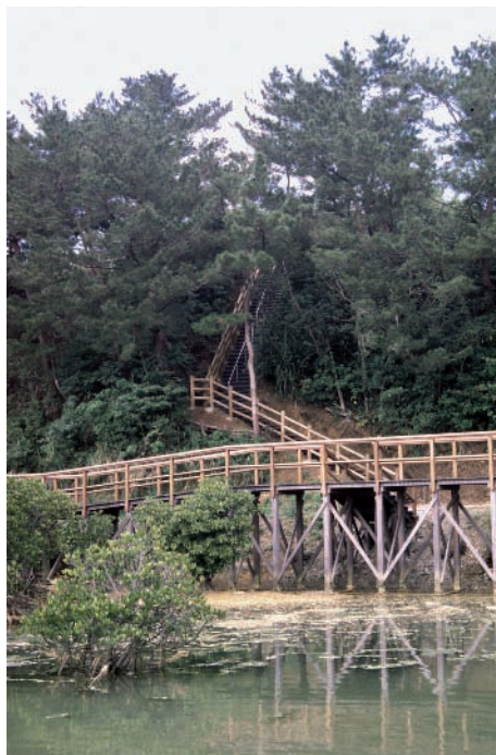
Ryc. 14. Bezpieczne, biegnące setkami metrów pomosty umożliwiają obserwacje mokradłowego fenomenu namorzynów z różnej wysokości (fot. K. Tobolski)
