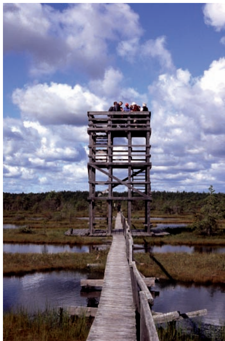
Ryc. 7. Bezpieczne wędrówki przez rozległe torfowisko Männikjärve raba w torfowiskowym kompleksie Endla zapewniają masywne kładki, mostki oraz wieże obserwacyjne (fot. K. Tobolski)
